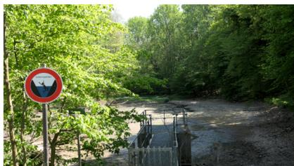
Der Rückstau des Hochwasserrückhaltebeckens in den Oberlauf des Holtorfer Baches soll minimiert und die ökologische Durchgängigkeit des Baches wiederhergestellt werden. Hierzu wird der Bachlauf umgeleitet, damit das Fließgewässer aus dem Dauerstau herausgenommen wird und es wird mit der Umleitung eine Verbindung zwischen Ober- und Unterlauf des Baches geschaffen.
