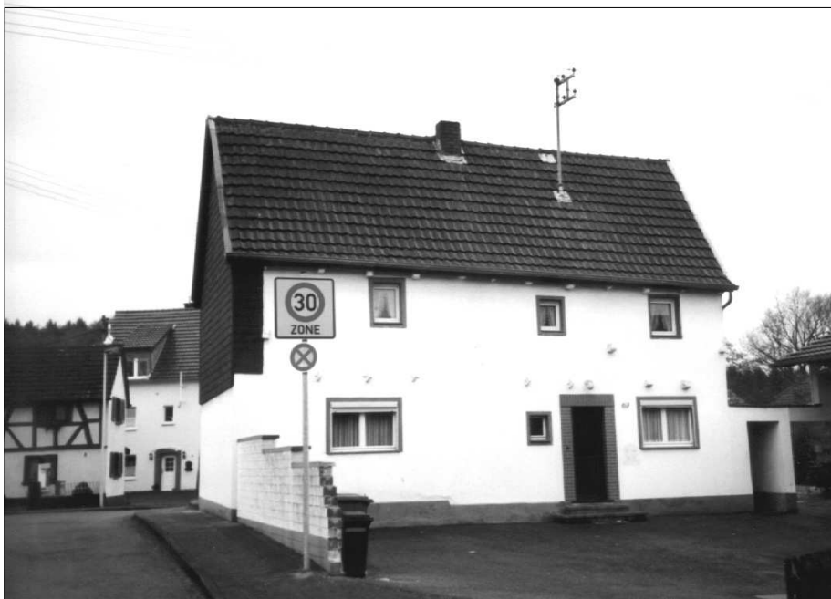
Das inzwischen abgerissene Lindersche Haus, Hauptstraße 67
